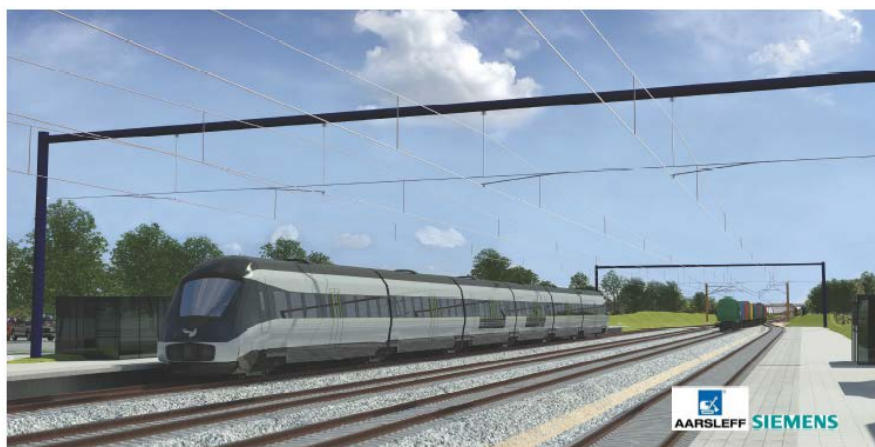
Figur 3: Visualisering af portalmaster ved dobbeltspor
