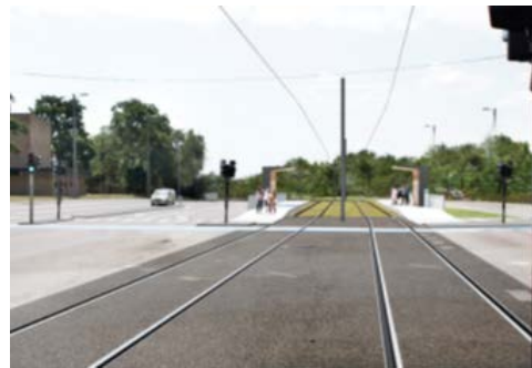
Anlæg med rilleskinnespor.
